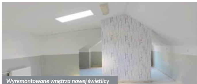
Wyremontowane wnętrza nowej świetlicy
