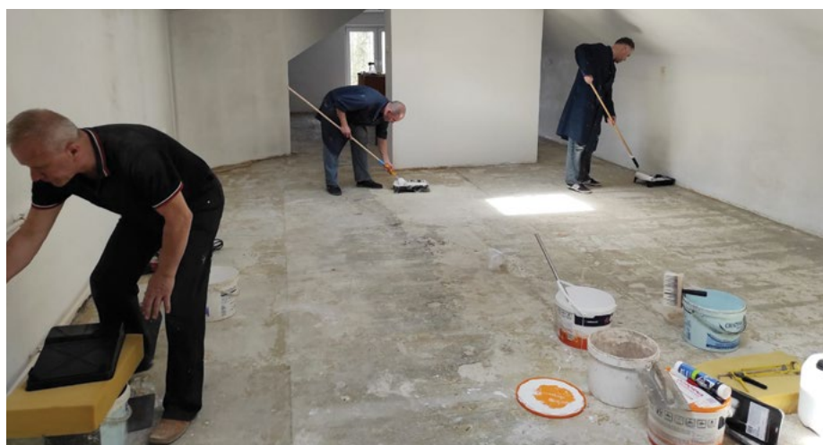
W ramach projektu „Dom Na Zawsze” wyremontowaliśmy pomieszczenie służące dziś jako pracownia rehabilitacyjno-terapeutyczna
