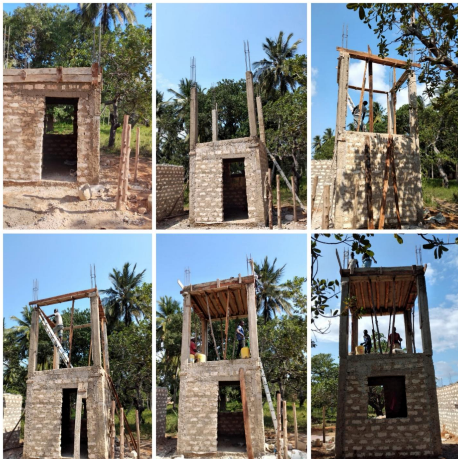
Construction d'un puits au Kenya avec Kenya Asante Sana Polska - Foundation
